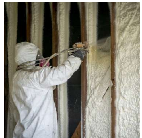
Penyemprotan PU Foam
